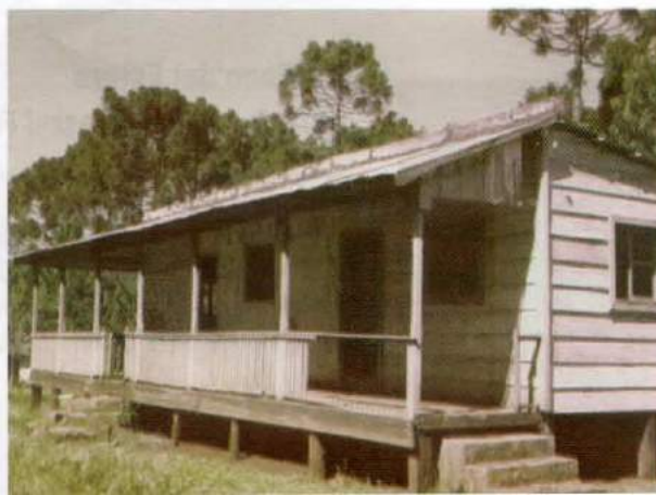
Antigua casa que funcionaba como Administración (Foto: septiembre, 1980).
