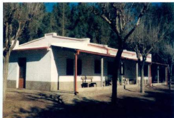
Casa principal. La puerta de la izquierda corresponde a la oficina, el resto del edificio es la vivienda del Jefe de la Estación (Foto: julio, 1982).
