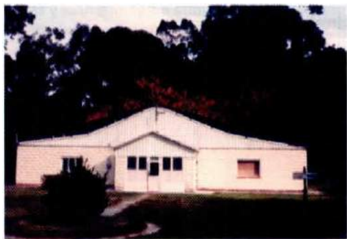
Cuerpo de edificio destinado para la oficina y el laboratorio (Foto: abril, 1984).
